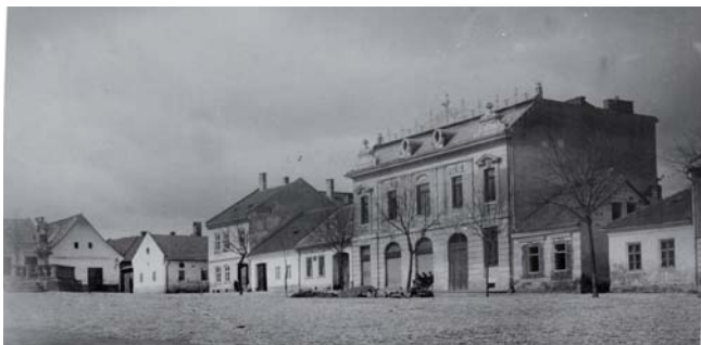
Reprezentativní dům čp. 167 nově vystavěný po požáru z roku 1896, střecha je korunována kovaným ornamentálním pásem, kterému dominuje ve středu situovaný nápis „P. LÖWI“.
